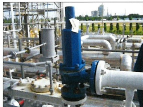
ภาพที่ 2.2-24 ระบบวาล์วนิรภัย (Safety valve)
