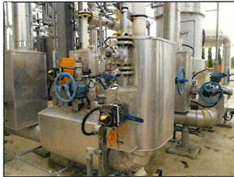
ภาพที่ 2.2-27 ระบบแรงดันเมื่อพบความผิดปกติของอุณหภูมิภายในถังที่ทำการฟื้นฟูสภาพสารดูดซับ
