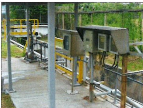
ภาพที่ 2.2-8 Continuous Analyzer บริเวณ Outfall Pit
